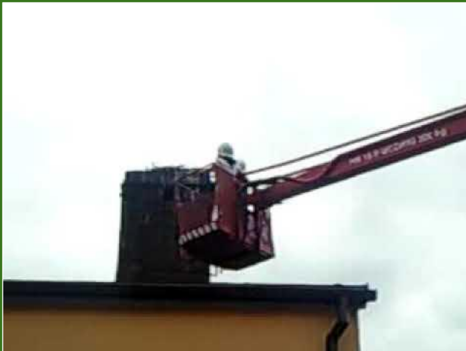
Demontaż platformy z komina I.
